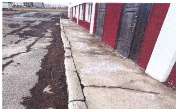
А блокийн засварын ажлын дараах байдал 2023.04.19 /хөрсний ус нэвчсэн, хаалга гажиж, явган хүний зам хагарсан байдал/
