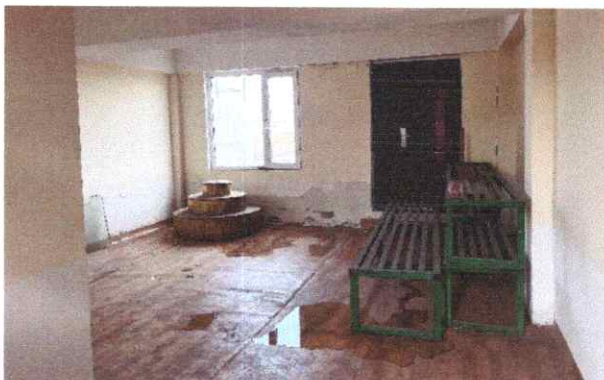
А блокийн засварын ажлын дараах байдал 2023.04.19 /хөрсний ус нэвчсэн, хаалга гажиж, явган хүний зам хагарсан байдал/
